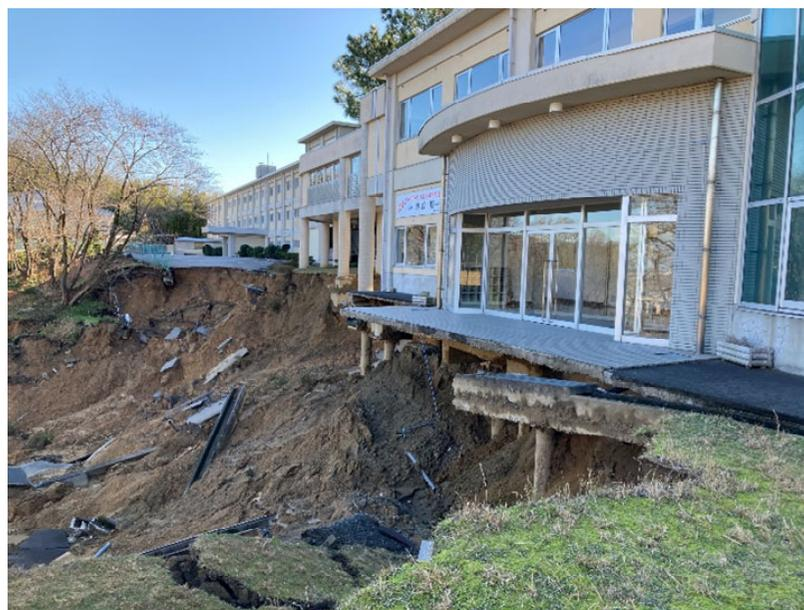
校舎前地盤が崩れ、地中杭が露出
